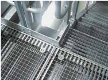
Bild 35: Fußleiste auf der Konstruktion
